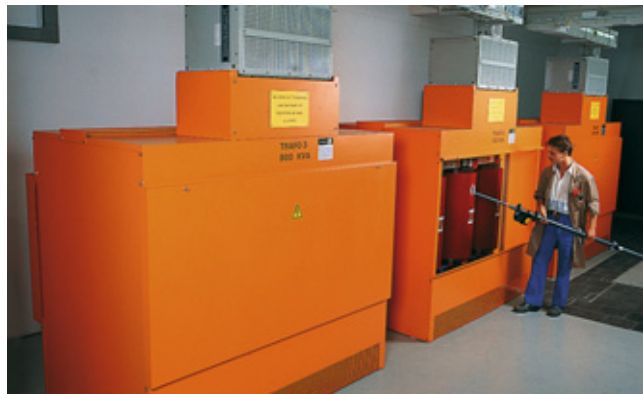
GEAFOL-Standardschutzgehäuse: z. B. nach Schutzart IP 20; auf Wunsch modifizierte Gehäusevarianten
