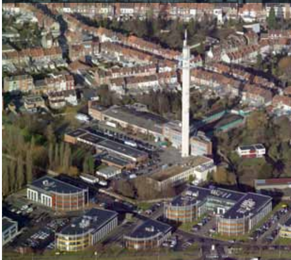
TDF - Un deuxième datacenter à Lille
