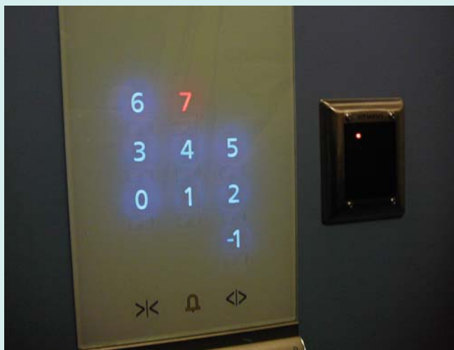
Ovládání výtahu s čtečkou čipů
